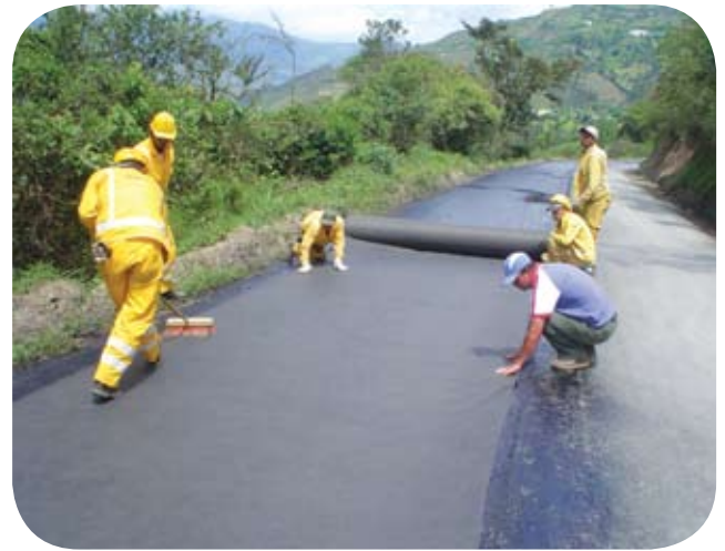
Vía Caqueza - Cundinamarca, 2007 (REPAV 400)
