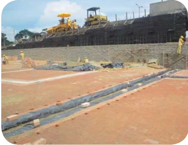
Muro en Suelo Reforzado
