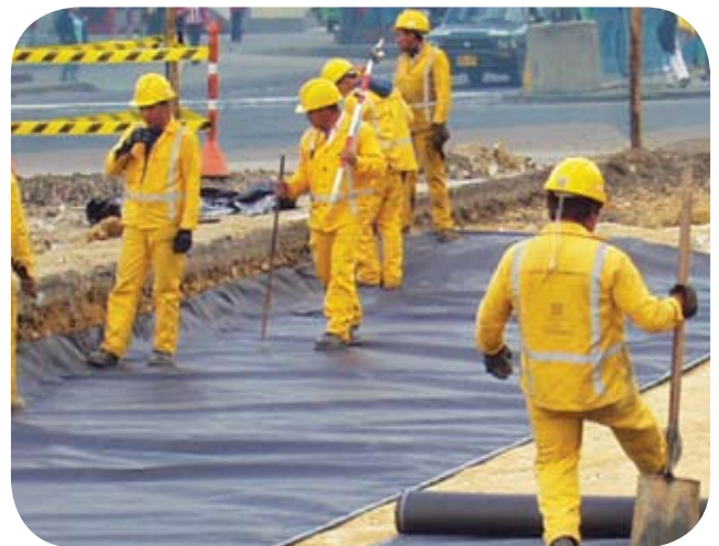
Troncal Transporte Masivo NQS sur tramo 1 Bogotá, 2005 (T2400)
