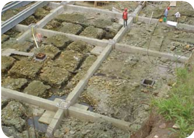
Centro Comercial Centenario - Cali, 2006, Geodrén Vial 100 mm / 0.50 mt
