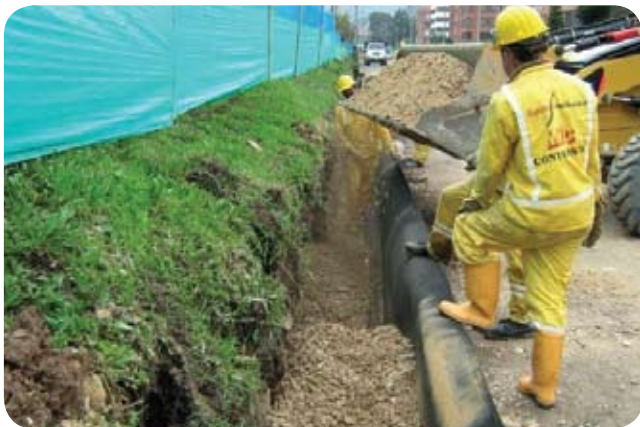
Avenida 9 Calle 127 - Bogotá, 2008 Geodrén Vial 100 mm / 1 mt
