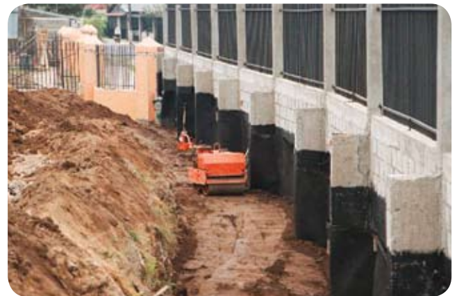
Urbanización Villa Andrea - San José, Costa Rica, 2006 Geodrén Vial 100 mm / 1 mt - Geodrén Planar 2 mt
